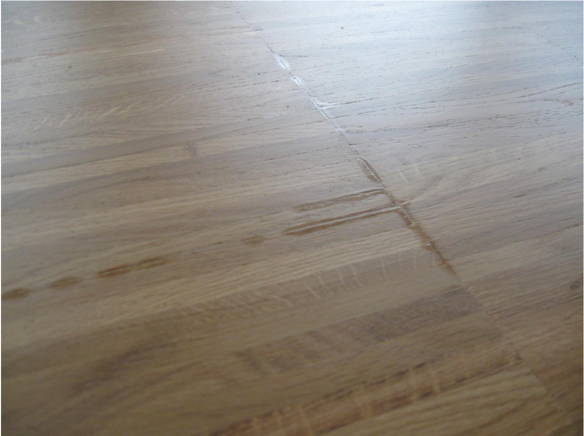
Bild: Glänzende Fugen bei Versiegelung mit einem matten Öl-Kunstharz-Lack
