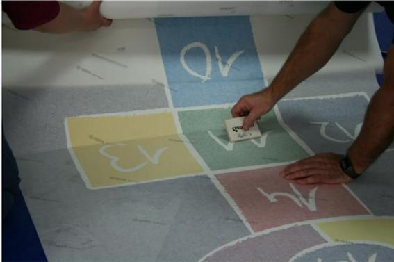
Si des bulles apparaissent, on peut les percer avec un cutter. L'air enfermé peut s'échapper par le point de piqûre.
